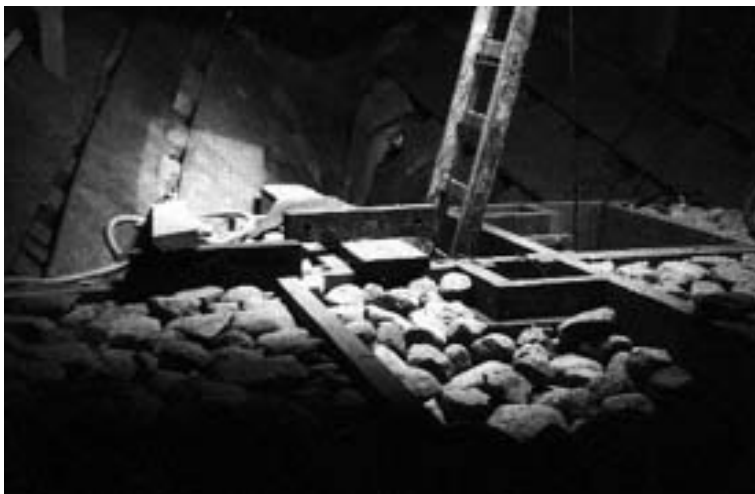
Abb. 20: Le lest avant le montage du sol
