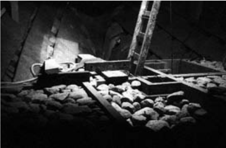
Abb. 20: Der Ballast vor dem Verlegen des Bodens
