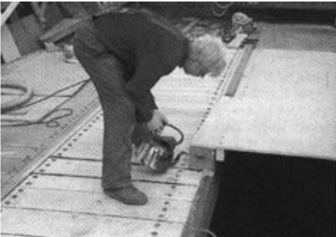
Abb. 12: Das Deck wird abgedichtet
